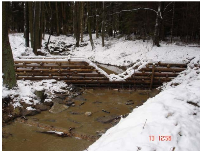
Pohľad na realizovanú zrubovú prehrádzku-vzor (zdroj: i-net)
